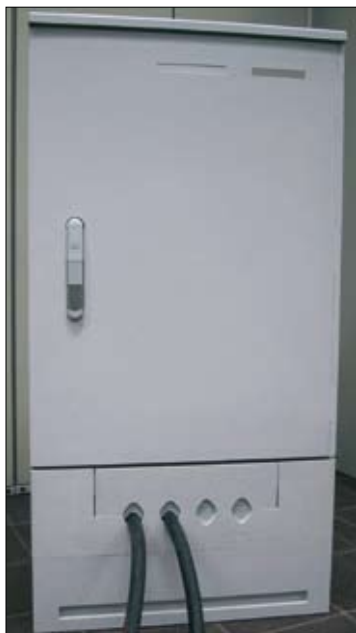
KV-Schrank mit Kurzsocket und Frontplatte Typ FP-KaVa* 2
